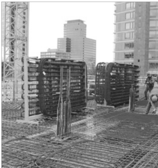
Подогрев и охлаждение ядра бетонных перекрытий
