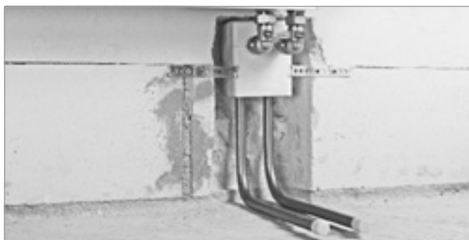
Присоединительный блок RAUTITAN для подключения отопительного прибора
