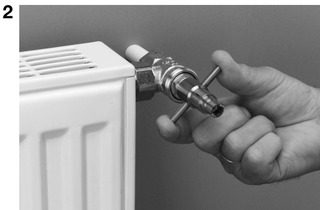
2 Выкрутить винт сальника (вода не польется, т.к. вентиль имеет дополнительное уплотнение.)
