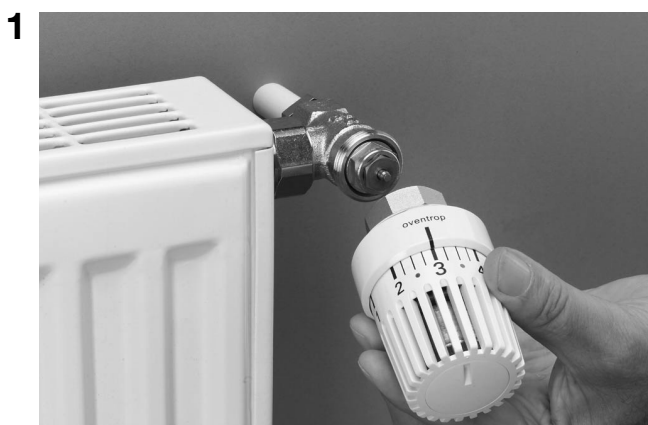
1 Снять термостат с вентиля.
