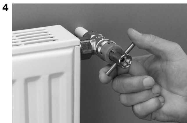
4 С помощью ключа настроечный винт закрутить до предела поворотом вправо.
