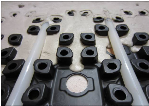
Рис. 1.1 Система монтажных матов с бобышками NP-R
